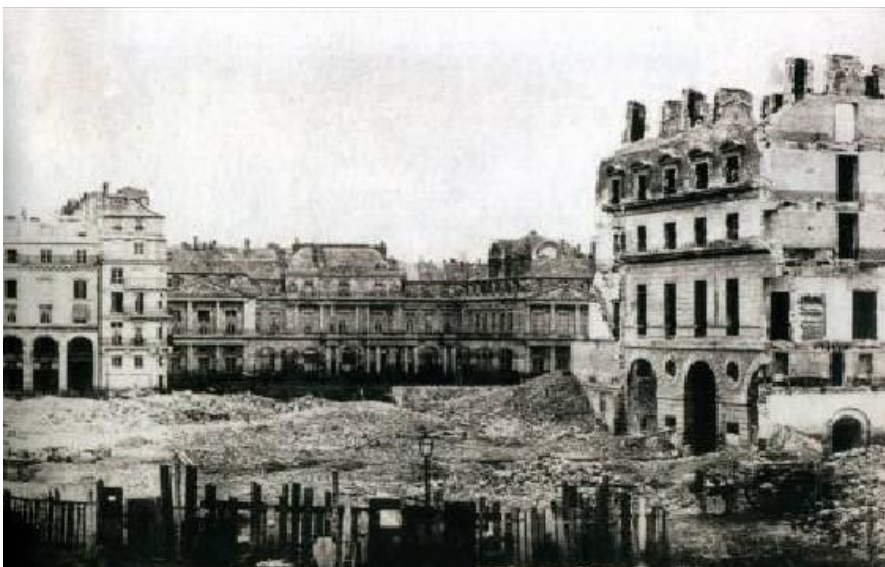
Travaux de démolition dans les années 1875
